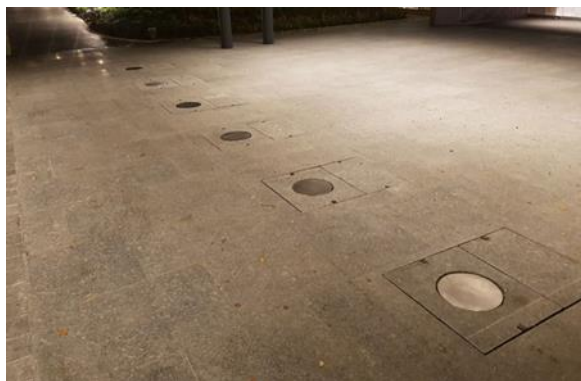
5. ábra. Süllyeszthető oszlopok a bejárat előtt Forrás: https://www.heald.uk.com/products/hostile-vehicle-mitigation/bollards/evo-bollard/
