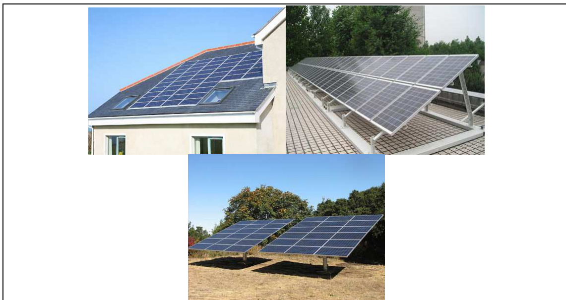
1. kép: Napelem ferde háztetőn, lapos tetőn és földre telepítve Forrás: [21]
